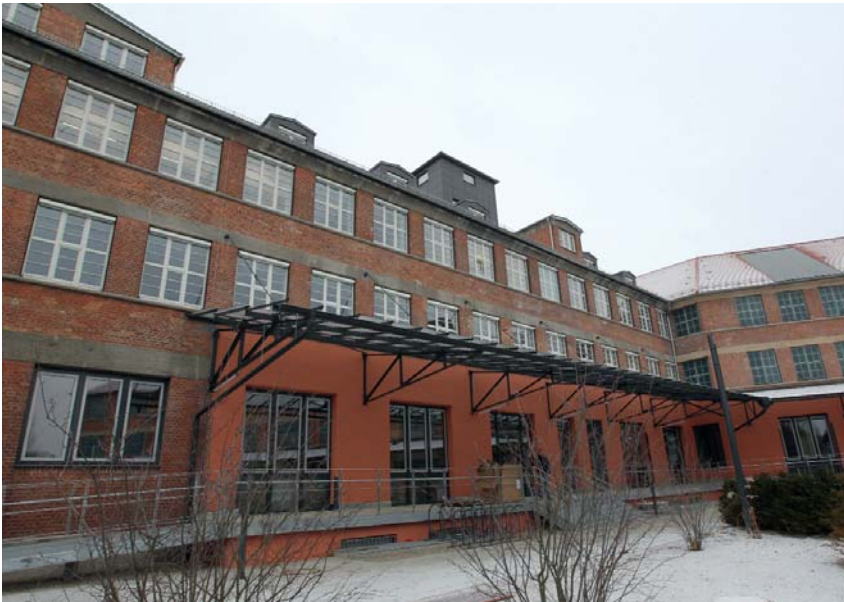
Der Innenhof mit dem Eingang und dem Magazinflügel.
